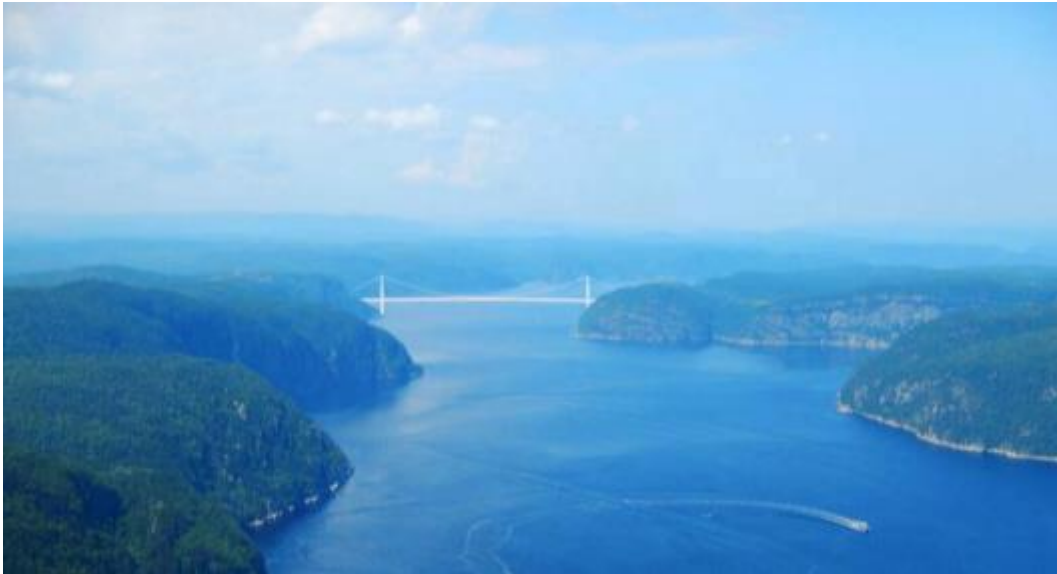
PONT AU SITE OPTIMALE : EN AMONT DE LA BOULE
