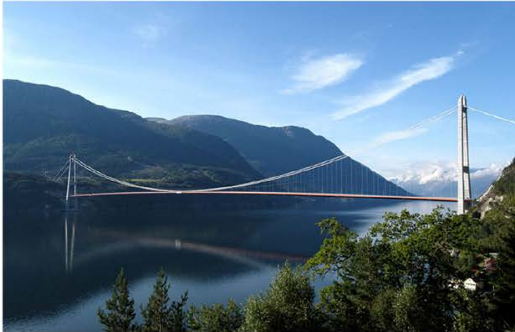
Pont Hardanger, Norvège
