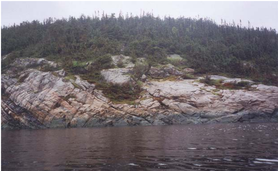
Photo 1-4 : Vue rapprochée de la zone d'implantation du pylône rive gauche
