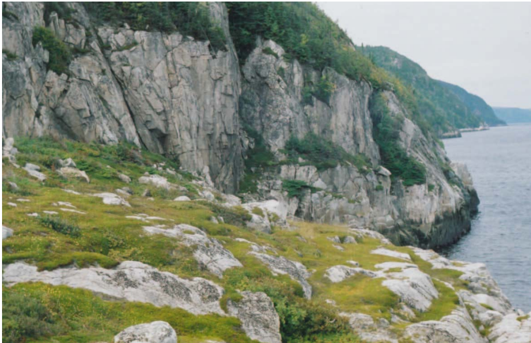
Photo 2-5 : Zone du pylône de rive droite. Vue vers le plan de faille situé en amont du pylône. Cette faille très longue marque la fin d'une zone d'aspect effondré sur laquelle repose le pylône.
