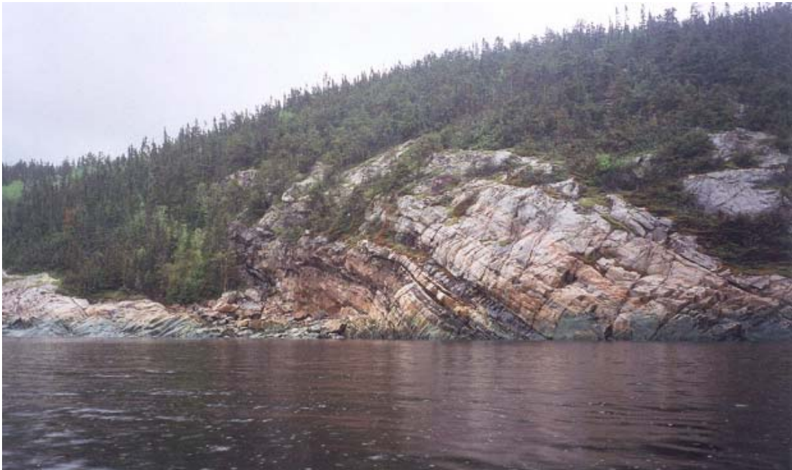
Photo 1-3 : Vue rapprochée de la zone d'implantation du pylône rive gauche
