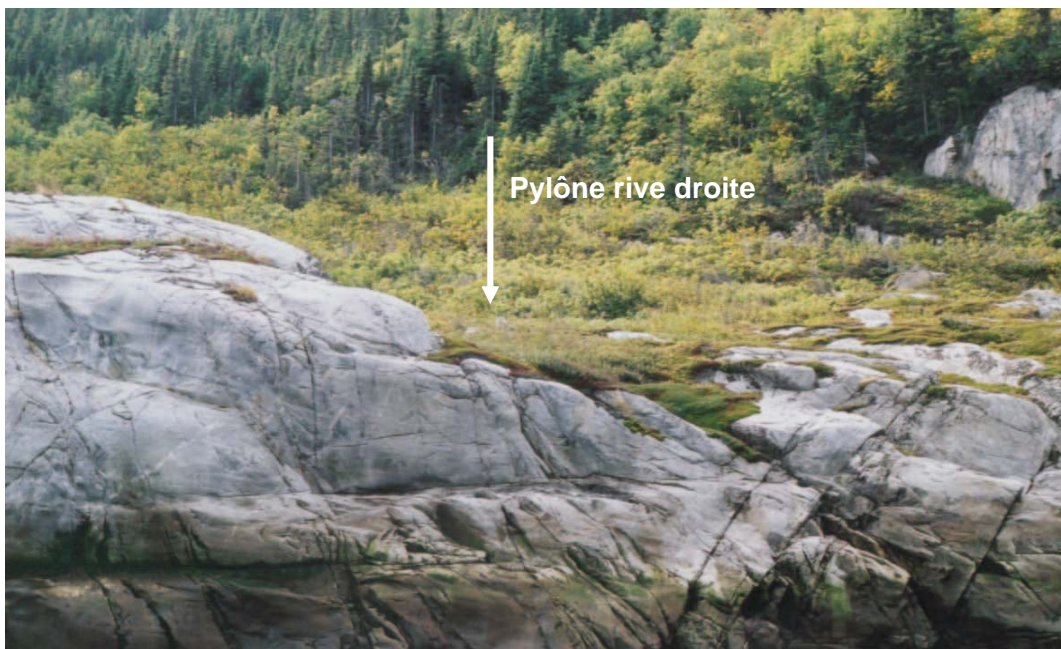
Photo 2-8 : Zone du pylône de rive droite. Le pylône est situé dans les broussailles au centre de la photo.
